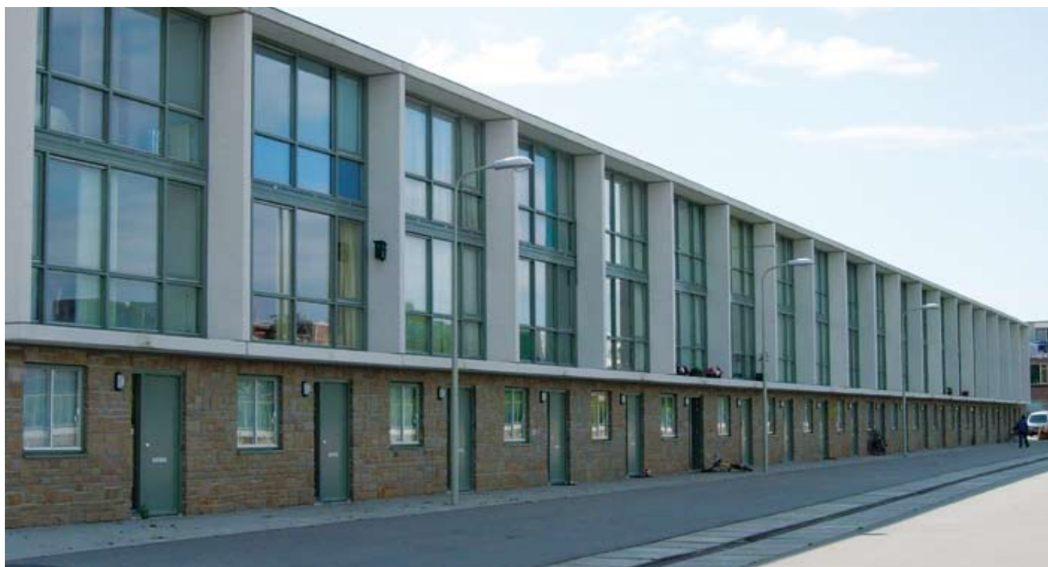
De 'Hof der Verademing' aan de Gaslaan in Den Haag is de winnaar van de WoonAward Haaglanden 2006.
