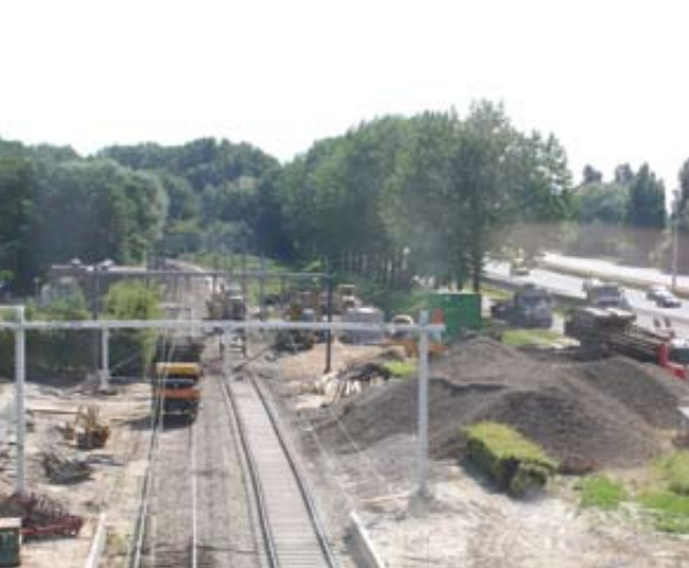
Tijdens de treinvrije periode van de afgelopen zomer werd gelijk 36 km spoor van de Zoetermeertlijn vervangen. Een megaklus!
