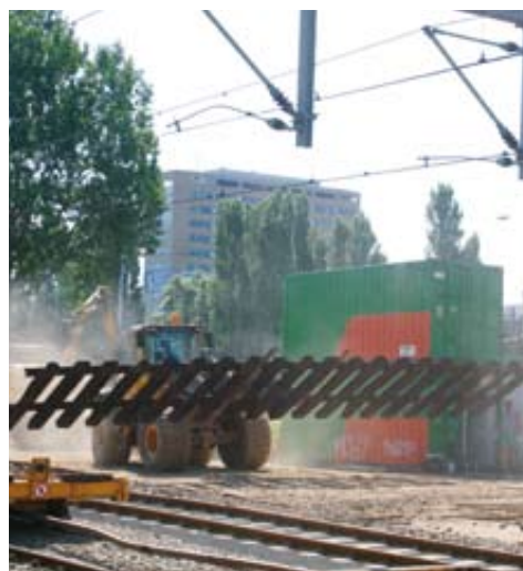
Tijdens de treinvrije periode van de afgelopen zomer werd gelijk 36 km spoor van de Zoetermeertlijn vervangen. Een megaklus!
